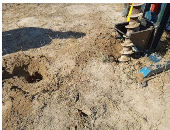
Рисунок 2. Процесс подготовки второй опытной площадки с расстоянием между шурфами 80 см.
